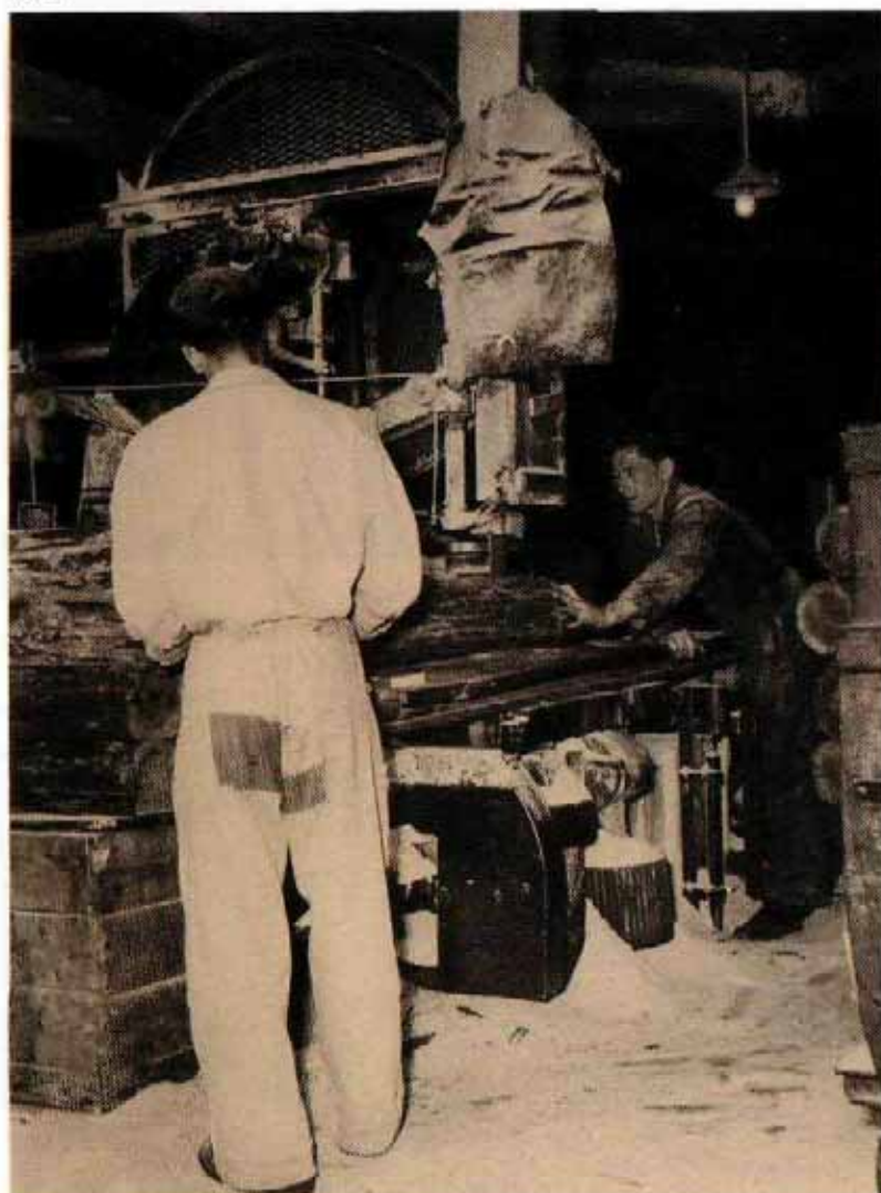
Mijnstutten worden gezaagd in de houtzagerij van de WIM, september 1949
