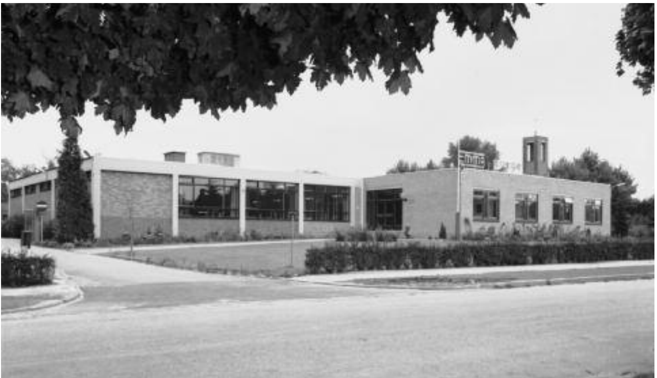
De nieuwe schoenfabriek Emma
